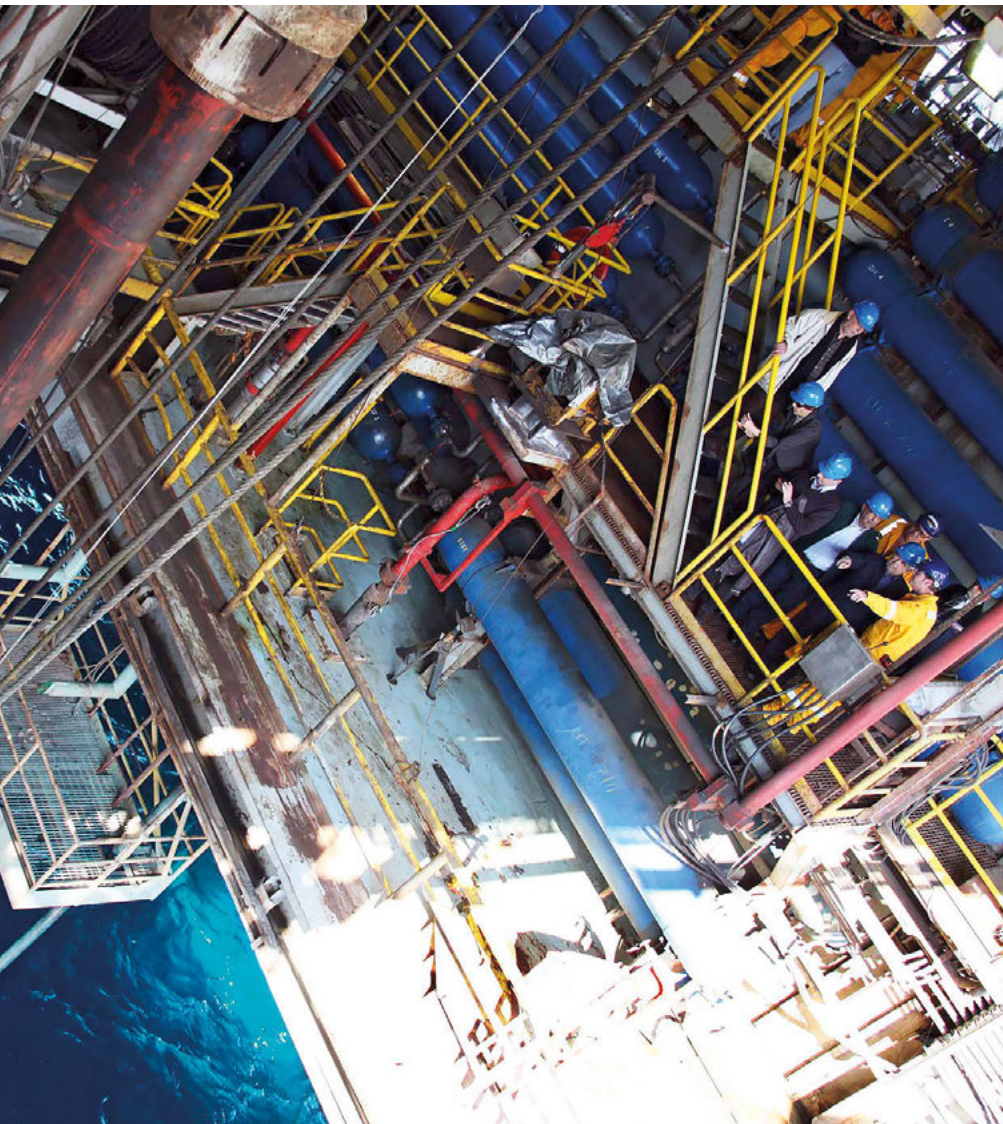
Tecnici al lavoro in un impianto di estrazione petrolifera nel Mediterraneo
